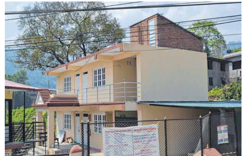
Im Distrikt Lalitpur wurde ein Stockwerk in erdbebensicherer Bauweise mit zwei Räumen für Geburten ergänzt.
