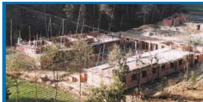
Beendigung des Rohbaus der Shangrila International School in 14 Tagen
